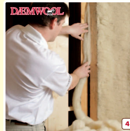
Leichtes Ausstopfen mit dem Dämmzopf
